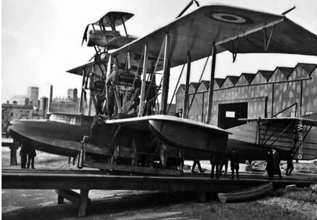
Самолет Felixstowe Porte Baby с закрепленном на нем бипланом Bristol Scout
